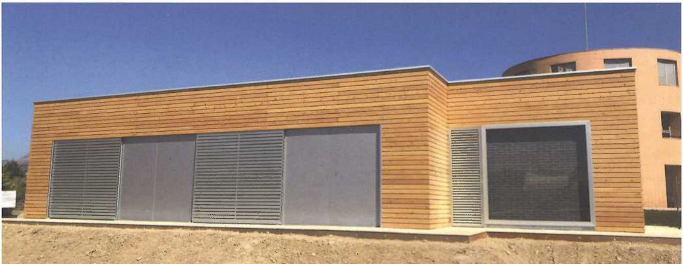
Secadero instalado por Valentia Huesca.
